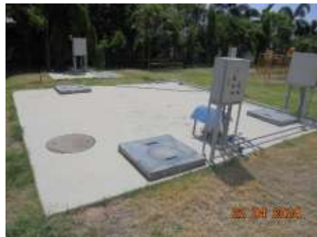
รูปที่ 13 ระบบบำบัดน้ำเสียสำเร็จรูป ขนาด 10 ลูกบาศก์เมตร
