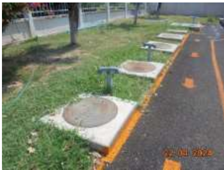
รูปที่ 13 ระบบบำบัดน้ำเสียสำเร็จรูป ขนาด 10 ลูกบาศก์เมตร
